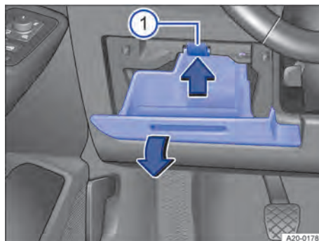
Abb. 179 Abdeckung des Sicherungskastens in der Instrumententafel: Linkslenker, links neben dem Lenkrad.
